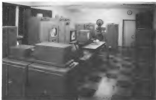
Bild 3. Der Zentralgeräteraum; im Vordergrund links die Farbdia-Anlage, im Hintergrund die Farbfilmabtastanlage, beide von der Fernseh GmbH
